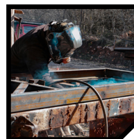
Réparation maintenance industrielle
