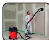
Aspiration de poussière de plâtre
