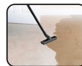
Aspirer les infiltrations d'eau
