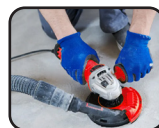
Poussières de béton et gravats
