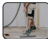
Nettoyage chantier /Atelier industriel
