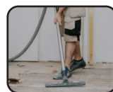
Nettoyage chantier /Atelier industriel
