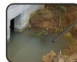
Vidanger eau stagnante
