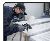
Rénovation intérieure (portes, meubles, volets)
